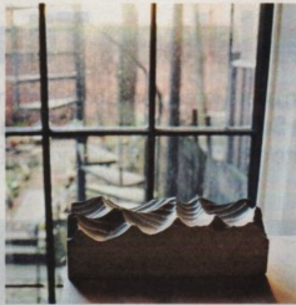
Bausteine des guten Klangs Aus 10 000 einzelnen Paneelen ist die Wand der Elbphilharmonie konstruiert. Hier ein Muster in Korens New Yorker Büro
