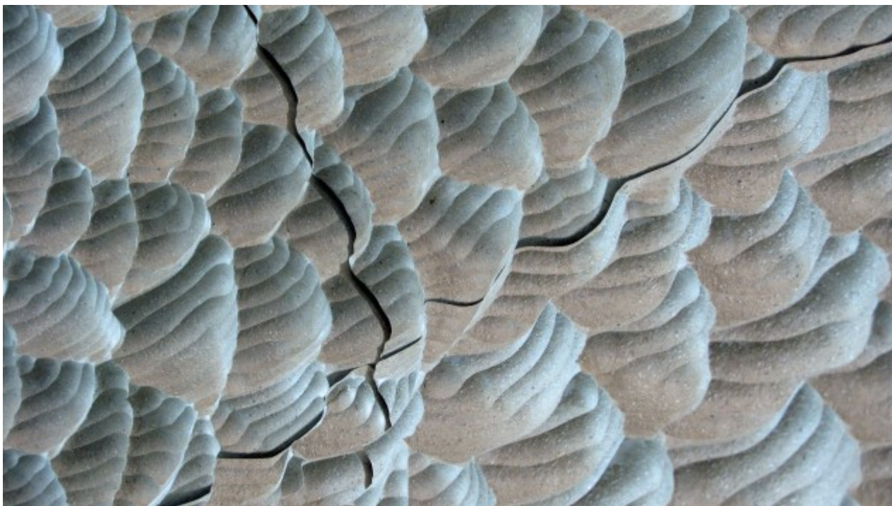
Elbphilharmonie: Die so genannte "Weiße Innenhaut" des Konzertsaals besteht aus zehntausend Paneelen, deren unterschiedliche Formen vom Computer berechnet wurden. (Foto: One-to-One)
